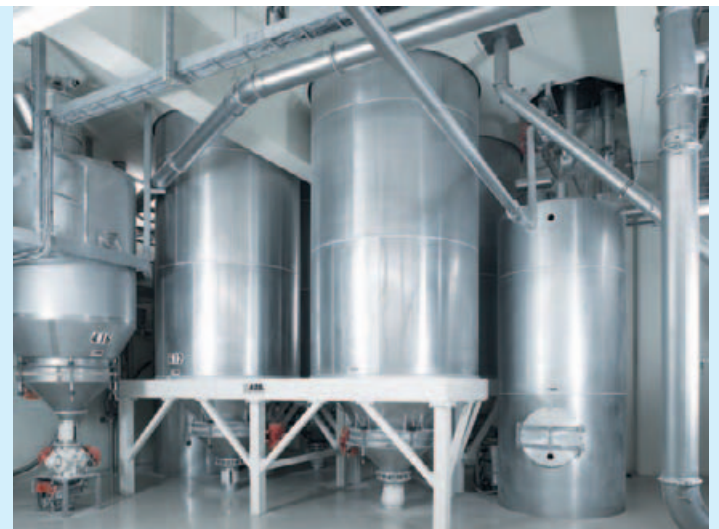
Beschickung von Innensilos zur Zwischenlagerung vor dem Abfüllprozess
