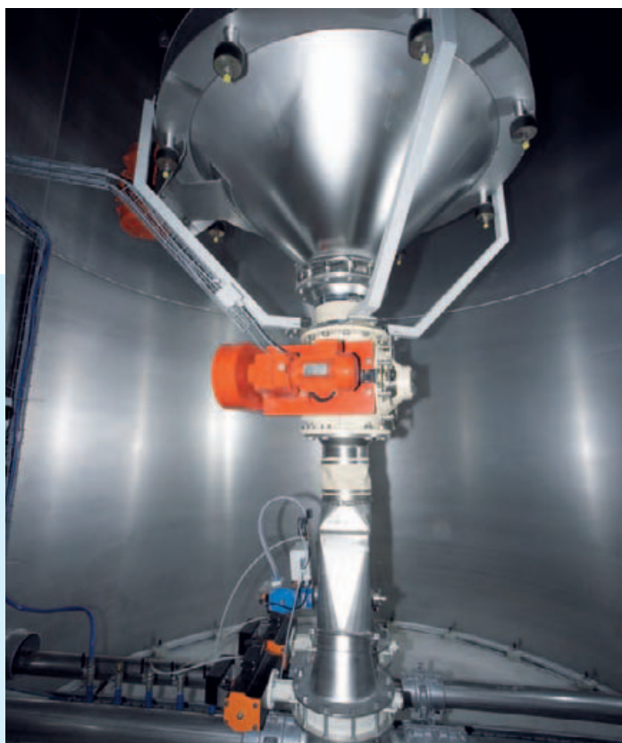
Austragung und Einschleusung in das pneumatische Saugwiegesystem
