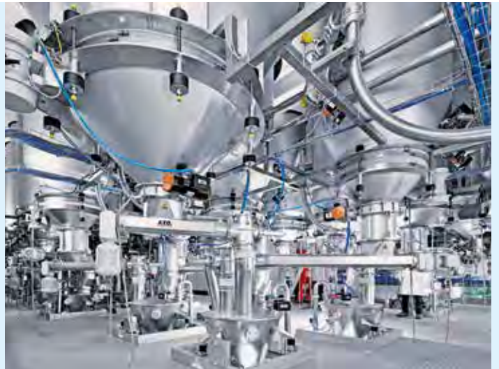
Auslaufbereich der Kochsalzsilos mit Vibrationsböden und Dosierschnecken
