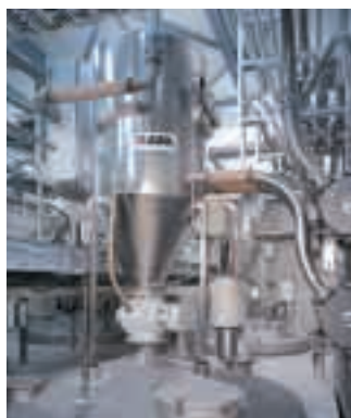
Beschickung von Puffersilos/Mischsilos
