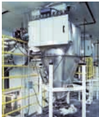
Abscheider mit groß dimensioniertem Filter
