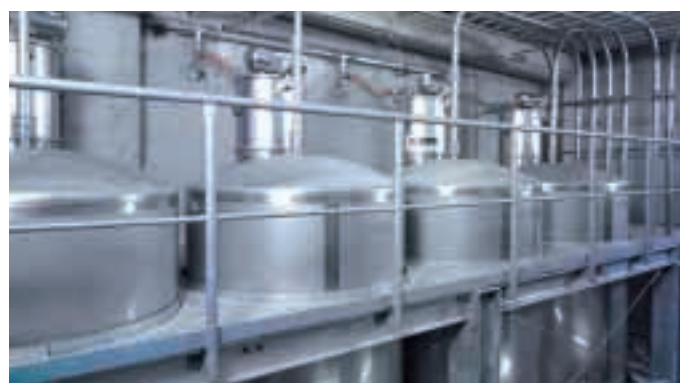
Puffersilos über den Abfüllanlagen
