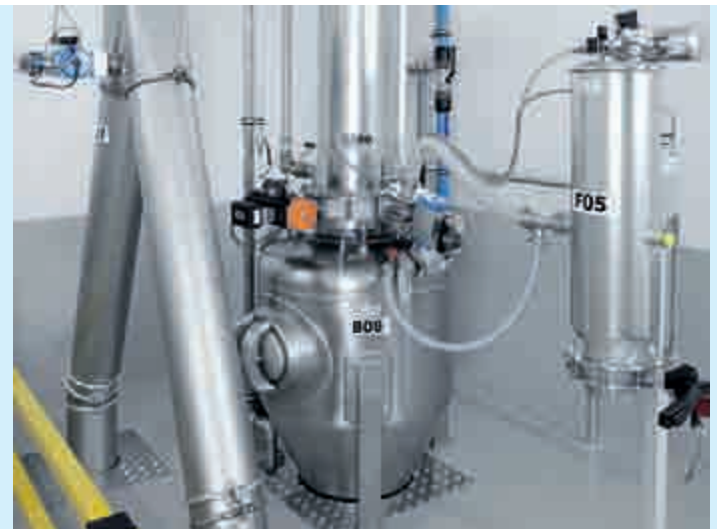
AZO®MULTIAIR Dichtstrom-Fördersystem zur schonenden Förderung des Fertiggranulats
