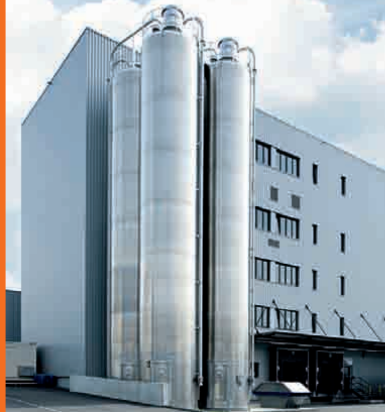
Außensilos zur Lagerung der Großmengen
