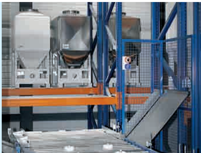
Hochregallager zur Zwischenlagerung der Mittel- und Kleinkomponenten
