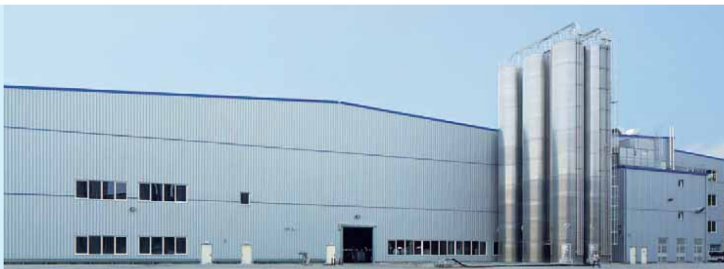
Produktionshalle mit Außensilos im Werk Niederrissen
