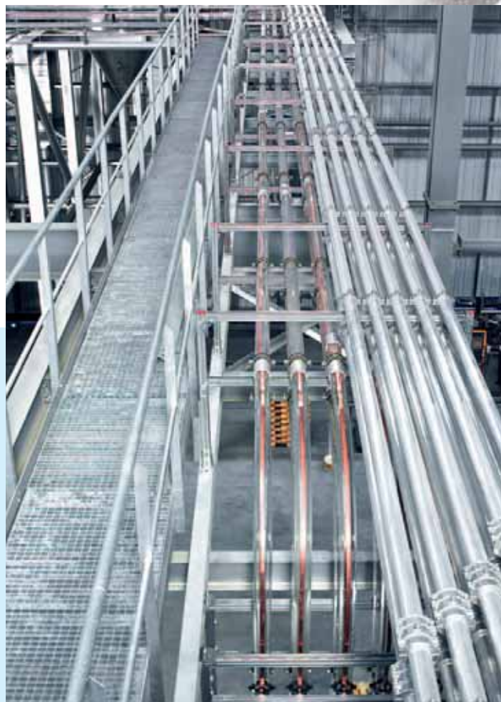
Förderleitungen aus Glas mit Kupfererdung reduzieren den Verschleiß bei abrasiven Produkten
