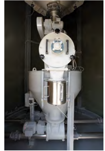
配有旋转筛分机和分配缓存罐的料仓底部
