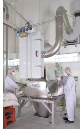
Doppelte Einfülltrichterstationen zum Befüllen der Innensilos mit Sackware
