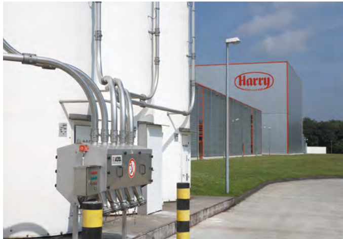
Außensilos für die Lagerung von Großmengen
