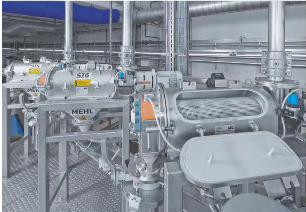
Wirbelstrom-Siebmaschine im Förderstrom zum Kontrollsieben von Mehl und Zucker
