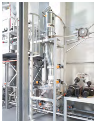
Förderwaage mit Druckimpuls-Sendegefäß
