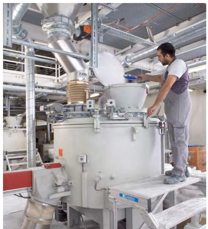
Mischerbeschickung mit Zugabe der Zuschlagstoffe, Farben und Additive
