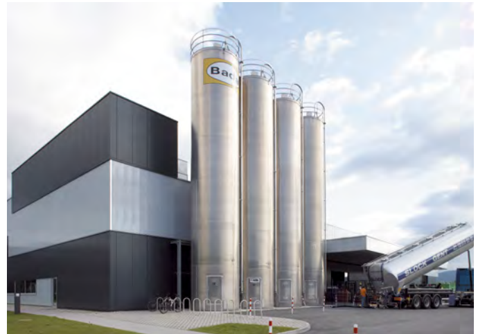
Lagerung der Großmengen in Außensilos
