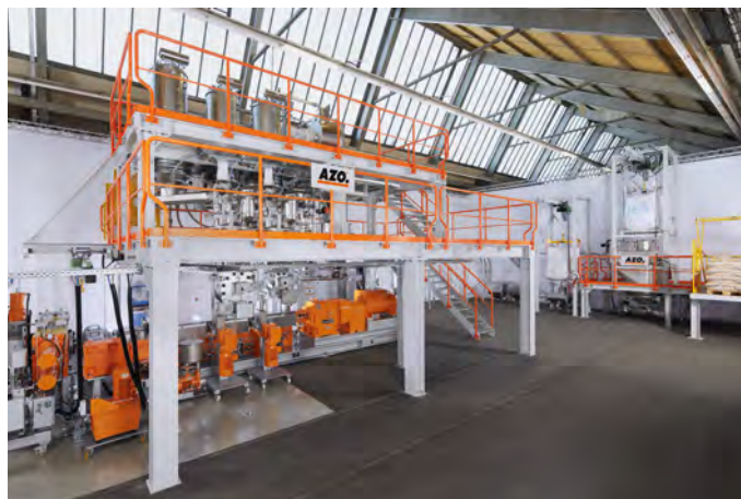
Rohstoffaufgabe, Dosierung und Extruder zur Herstellung hochgefüllter Compounds
