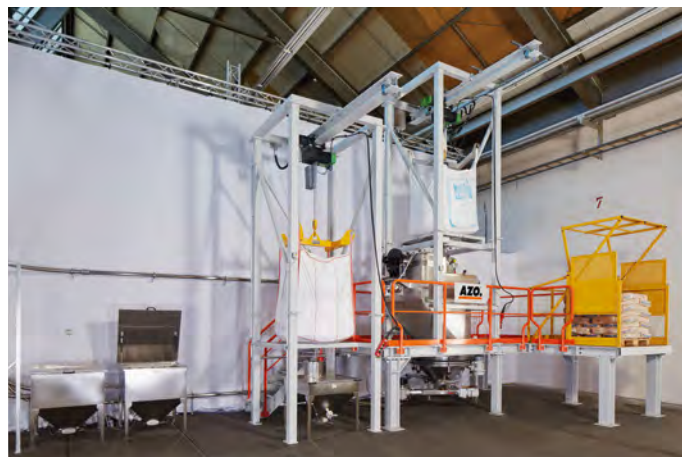
Staubarme Produktaufgabe von pulver- und granulatförmigen Rohstoffen
