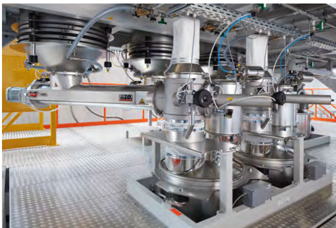
Die Befüllung der AZODOS®-Geräte erfolgt über Dosierschnecken
