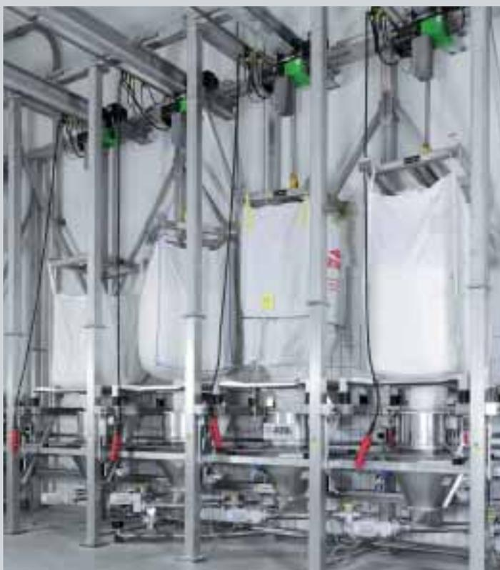
Big-Bag Entleerstationen mit Puffergefäß und nachfolgender Eindosierung in pneumatisches Fördersystem
