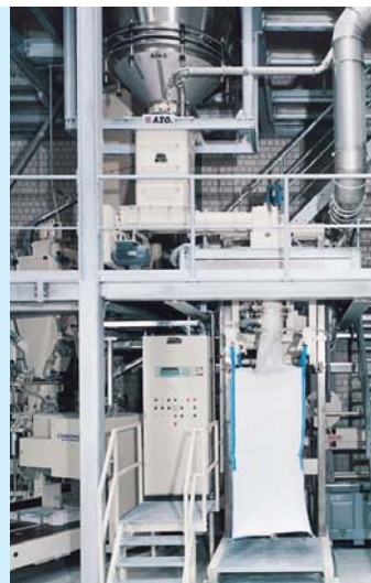
Automatisiertes Befüllsystem mit obenhängender Waage
