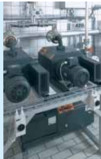
Vakuumpumpen als Unterdruckerzeuger
