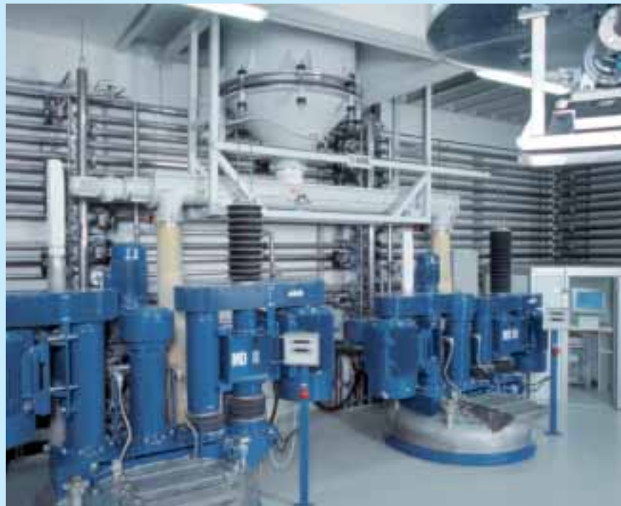
Beschickung von Dissolvern im Bereich Klebstoffherstellung
