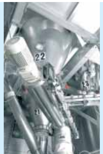
Förderwaagen mit Dosierschnecke
