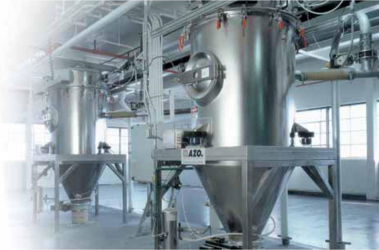
Mischerbeschickung im horizontalen Materialfluss im Bereich Fertiggerichte
