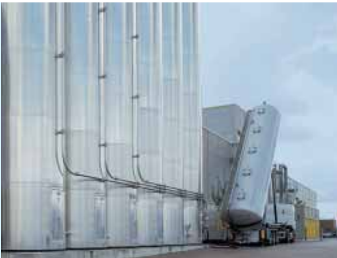
Rohstofflagerung in Außensilos
