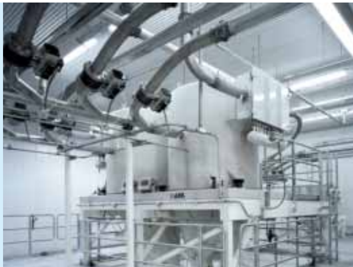
Mehrere Förderleitungen führen auf eine gemeinsame Ventilweiche
