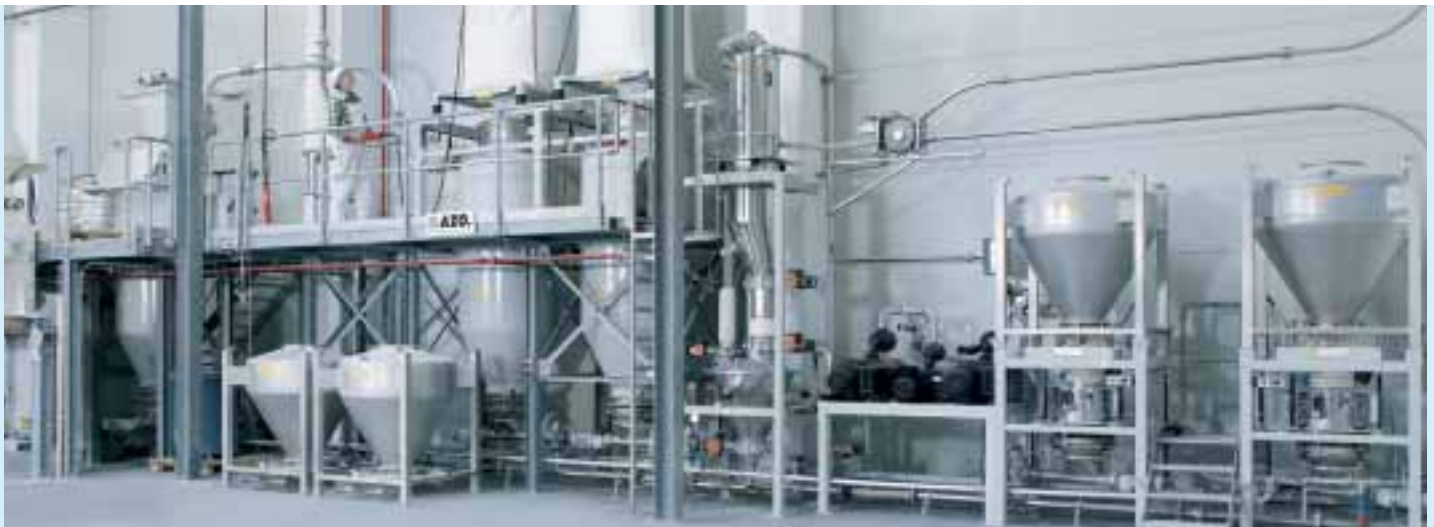
Horizontaler Materialfluss durch Saugwiegesysteme
