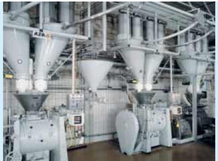
Empfangsbehälter für Mehl und Zucker in einer Anlage mit Zentralwiegesystem
