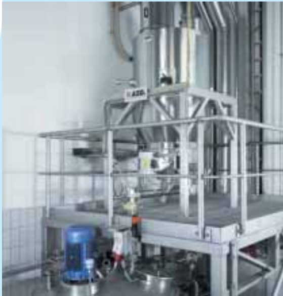
Förderwaage über Rührwerkbehälter in der Milchindustrie
