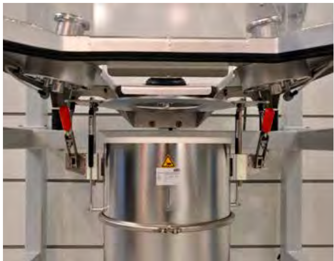
Big-Bag Anschlussystem für pulverförmige Schüttgüter
